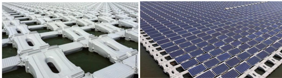
Exemple de flotteurs sans et avec panneaux solaires (source AKUO)
