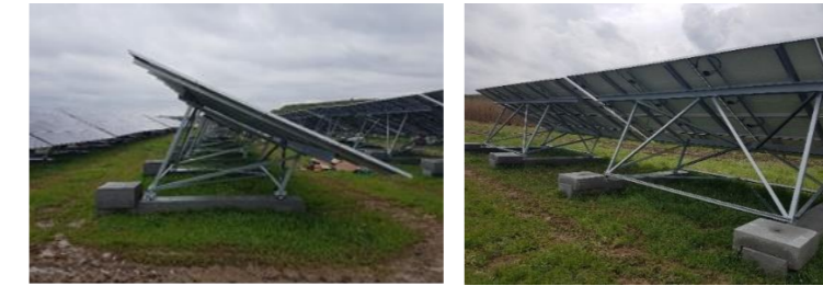
Exemple de fondations béton – Q ENERGY France
